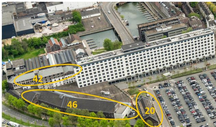
De 3 gebouwen die getransformeerd worden tot appartementen
